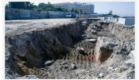
Imagen del inicio de las obras. / MANUEL FERNÁNDEZ
